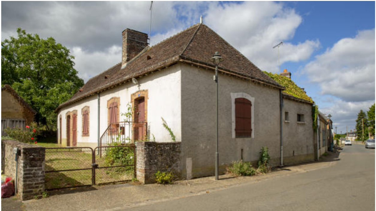
Une maison ou petite ferme de la 1ère moitié du XIXe siècle, rue Principale.
