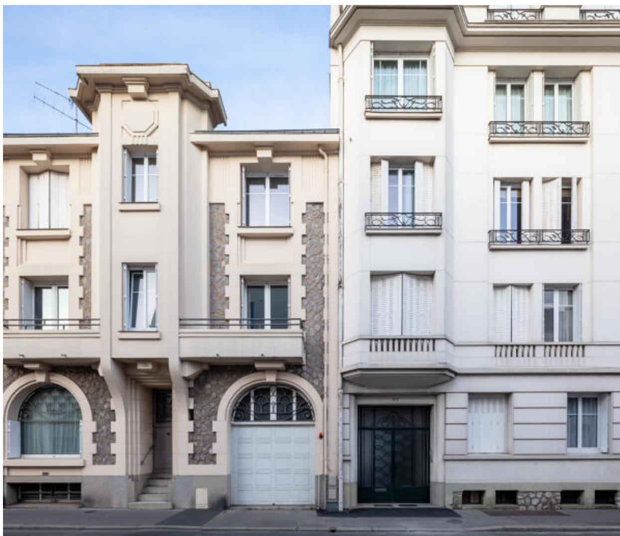
Vue de la travée nord de l'immeuble et de la maison voisine.
