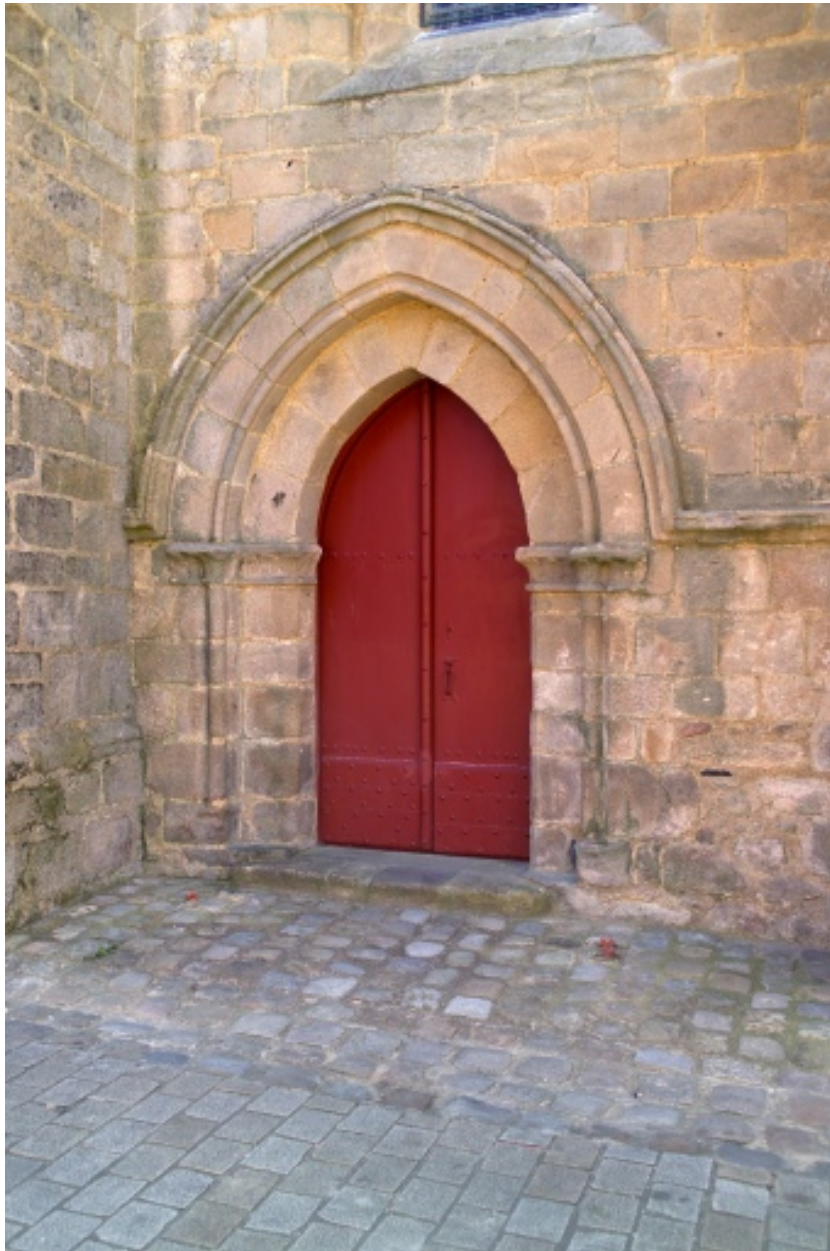
Mur nord, portail central.
