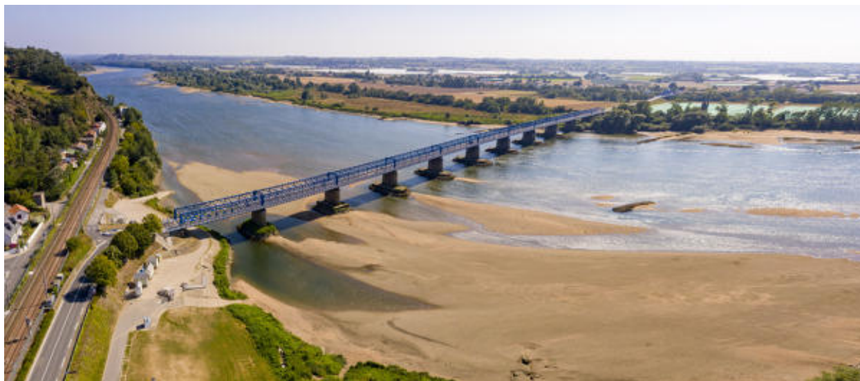
Vue aérienne des ponts de Mauves.
