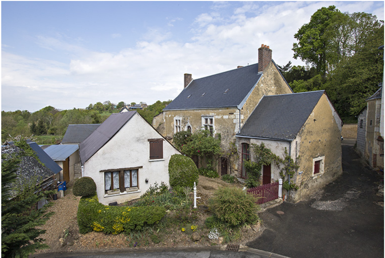
La maison dans son environnement, vue depuis la rue du Tusson.
