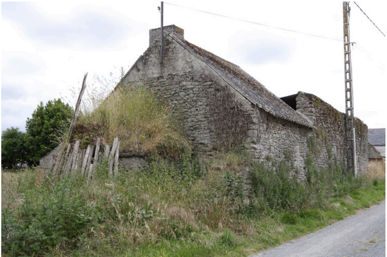
Fournil. Vue depuis le nord-ouest.
