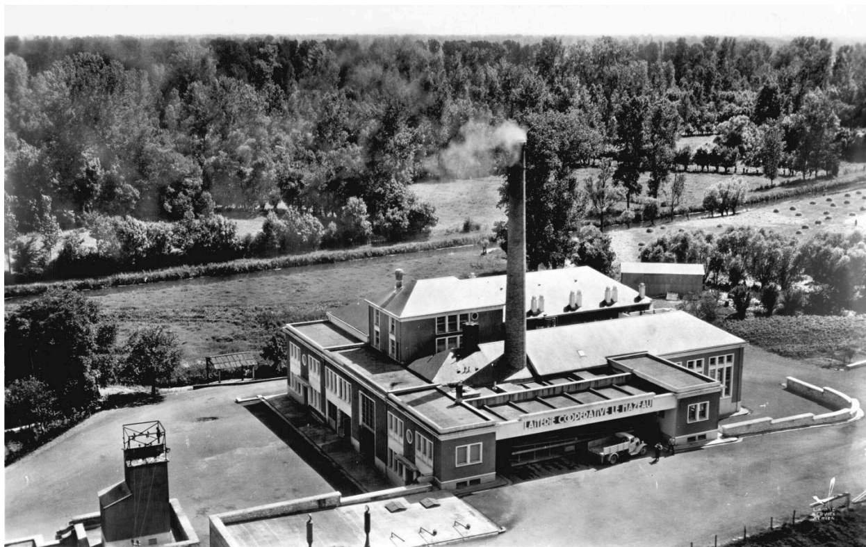
Vue aérienne de la laiterie depuis le nord en juillet 1959.
