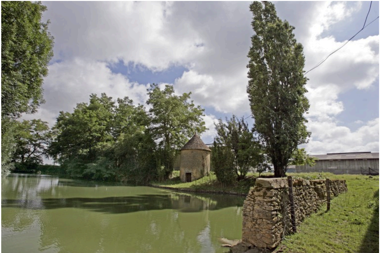
Four à chanvre : vue depuis la cour.
