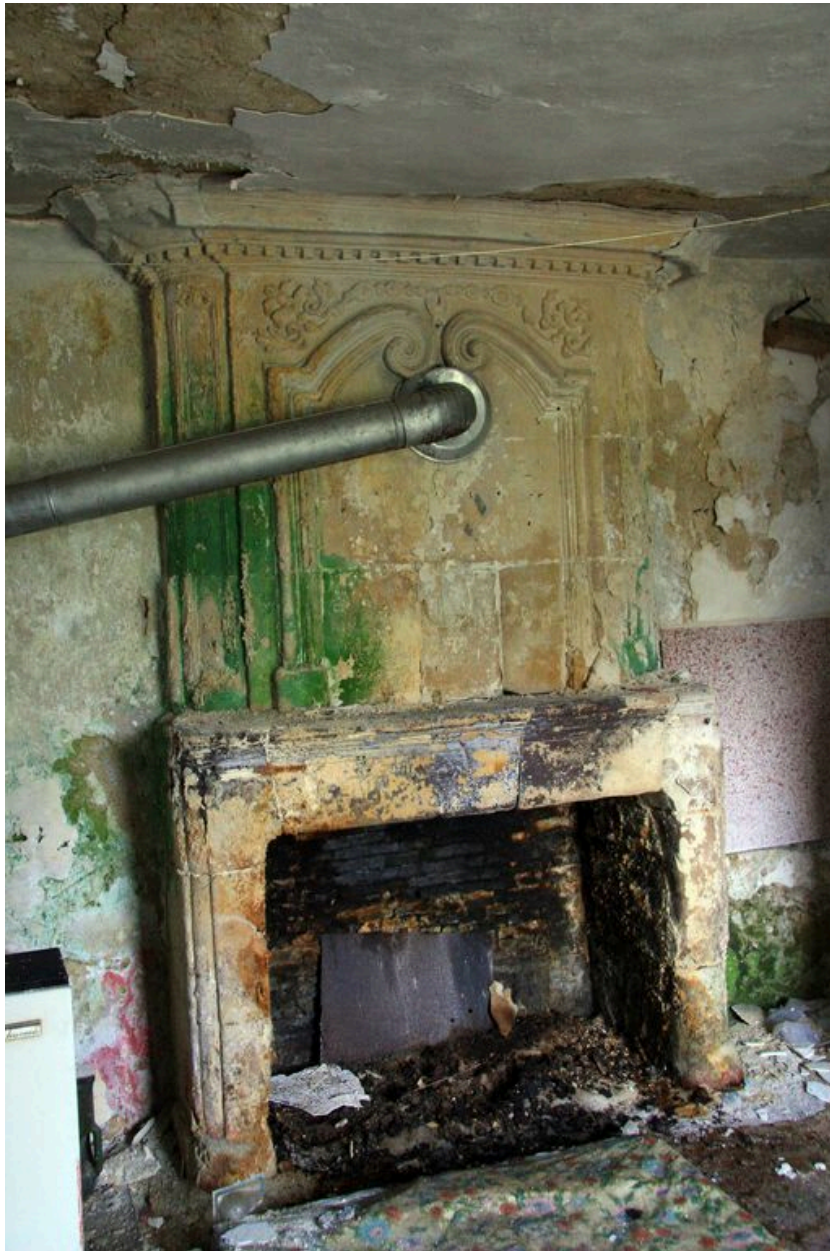
Rez-de-chaussée : cheminée sur mur gouterot.
