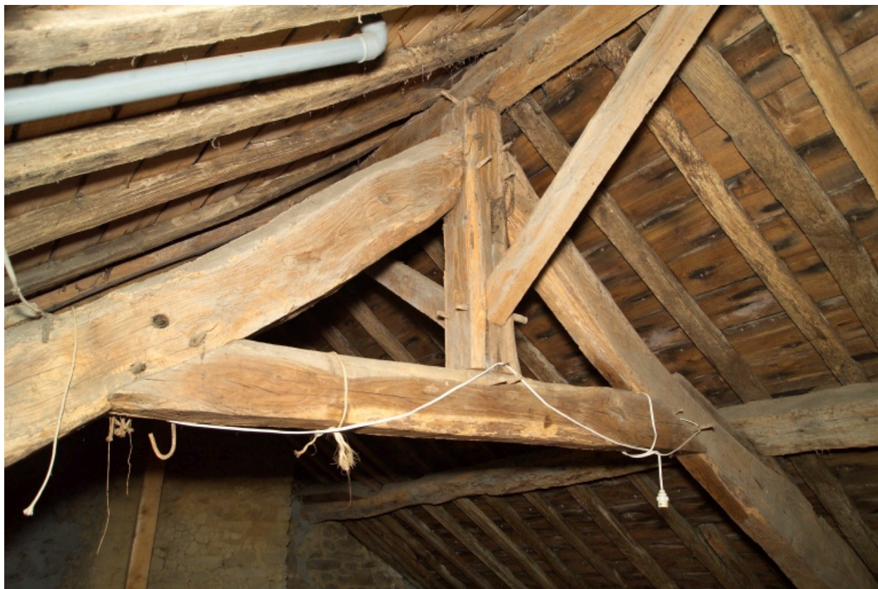
Charpente, détail de la ferme.
