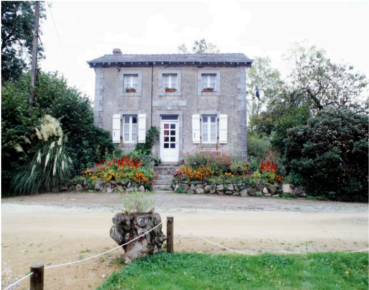
La maison éclusière.
