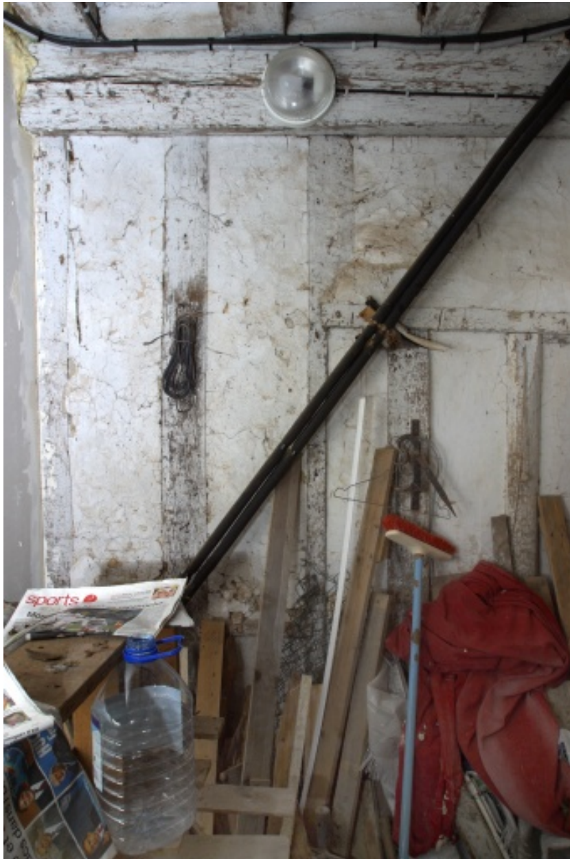
Mur intérieur de la cage d'escalier.
