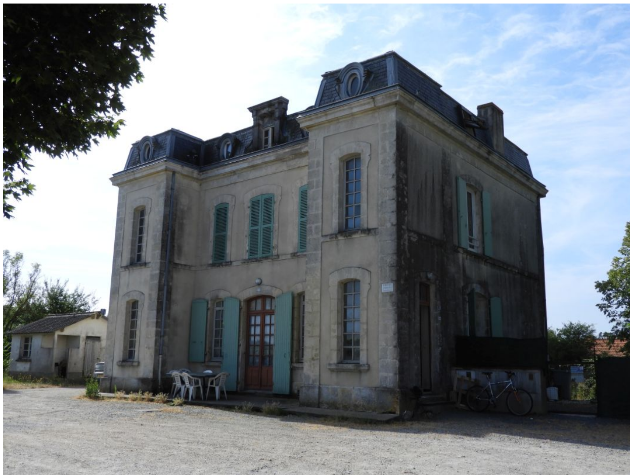
L'ancienne gare vue depuis le nord-ouest.
