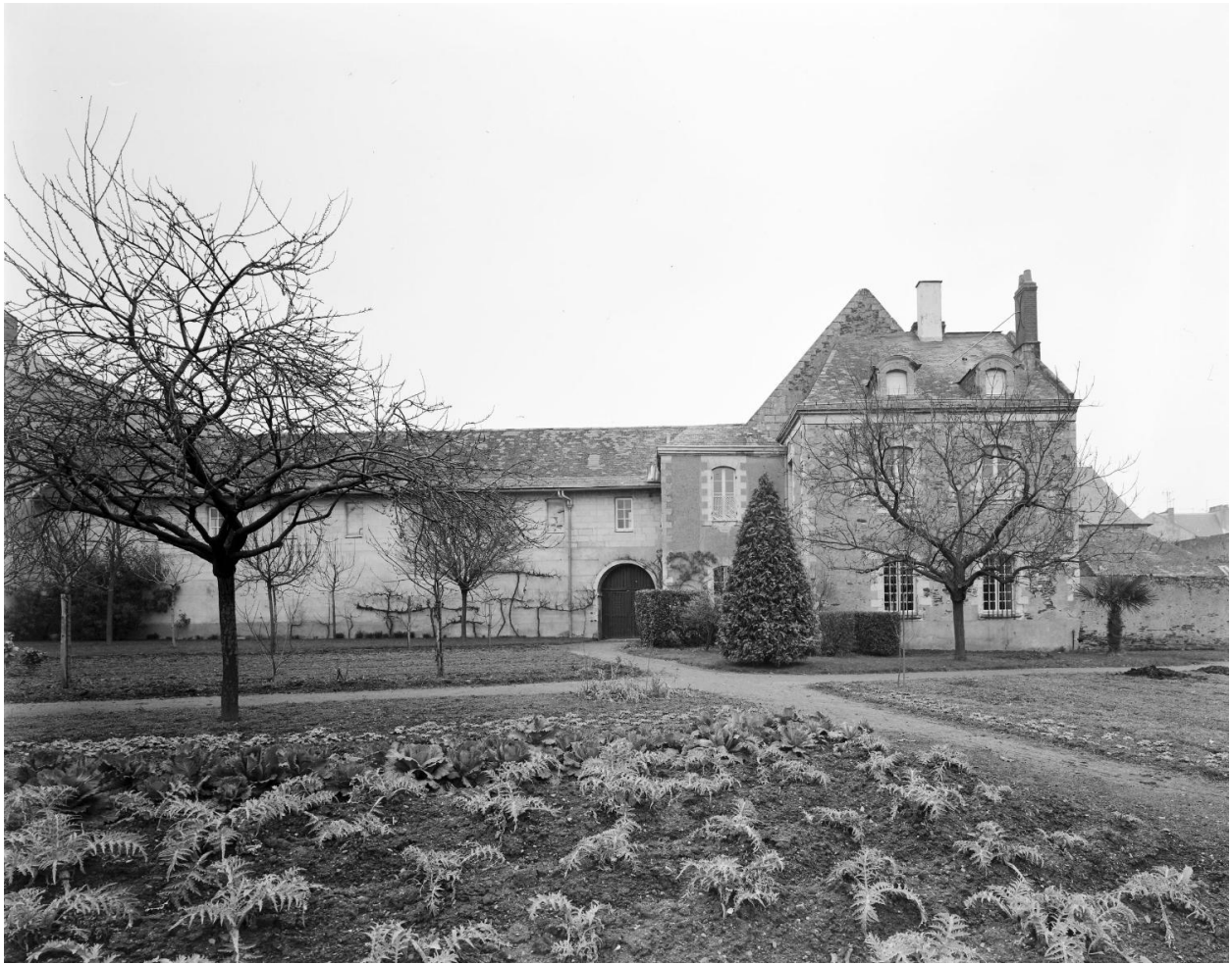
Aile ouest du cloître et bâtiment de l'infirmerie (d'après plan Baldet 1961) : façades ouest, sur jardin.
