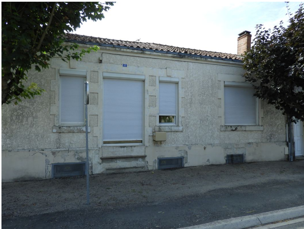
Les ouvertures de l'ancien café sur l'avenue, à l'ouest.
