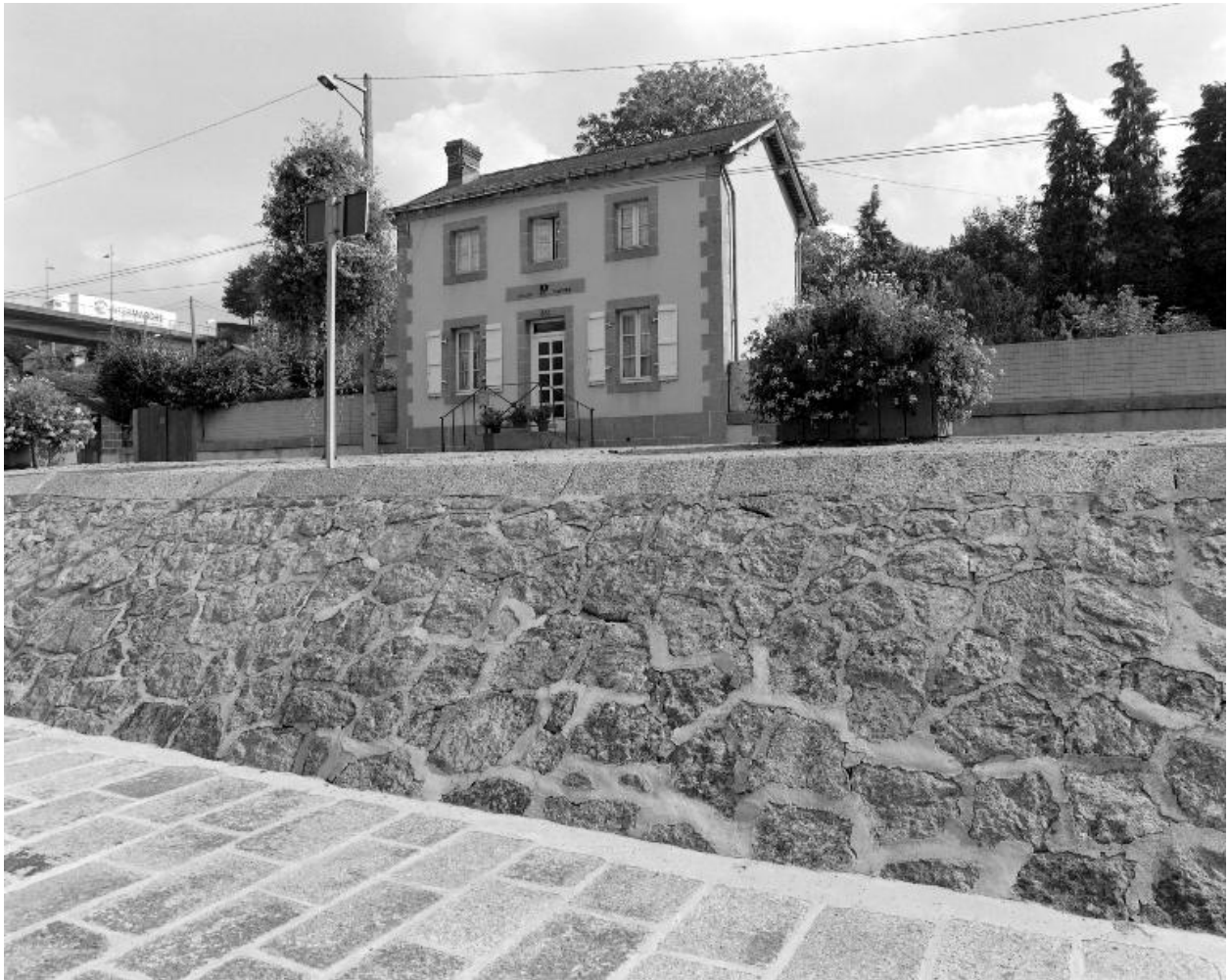
La maison éclusière.
