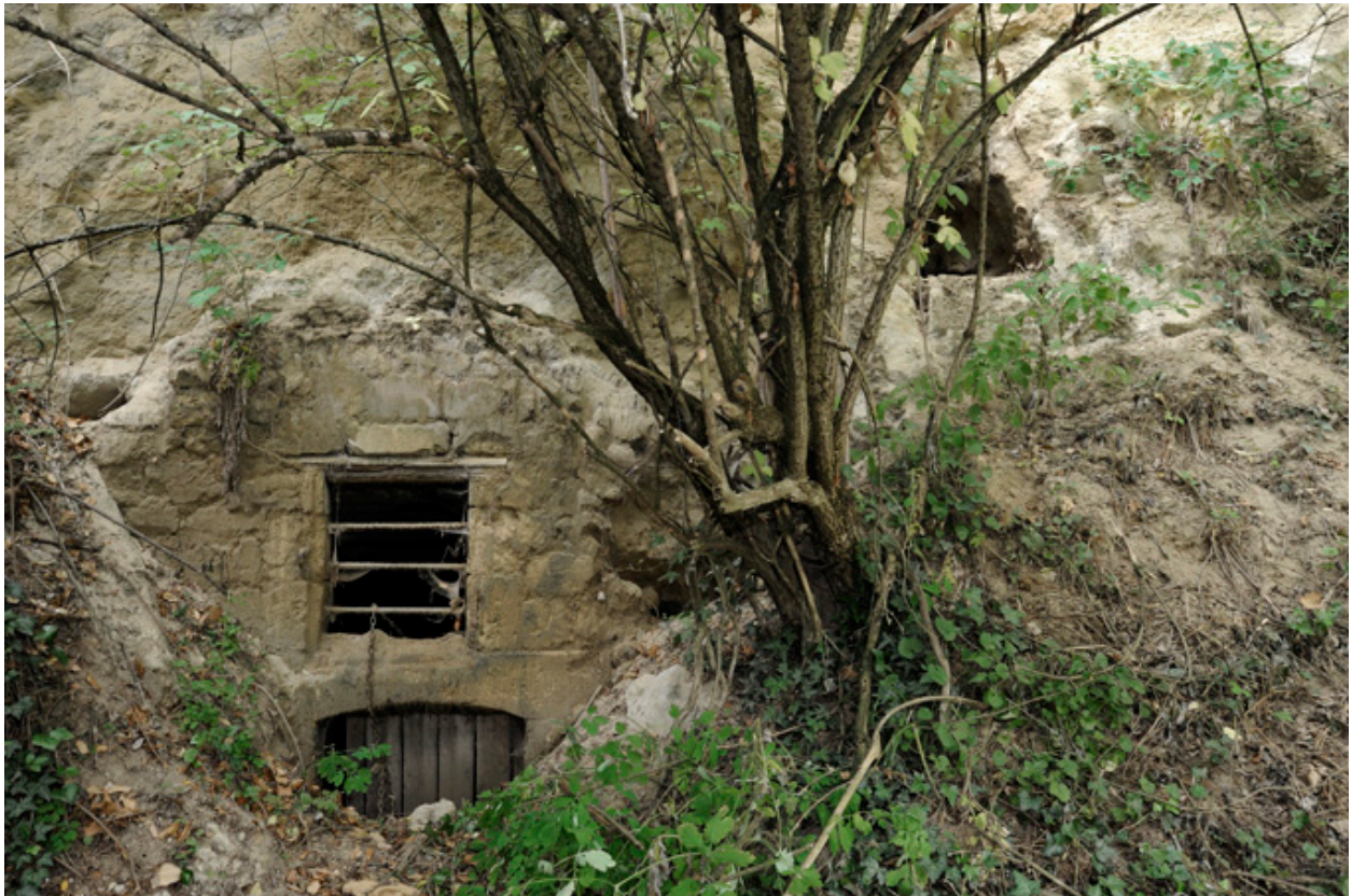
Abri troglodytique (cave à cheminée du XVIIIe siècle) de la parcelle F 955 (cadastre 2011) : porte avec imposte, cheminée.
