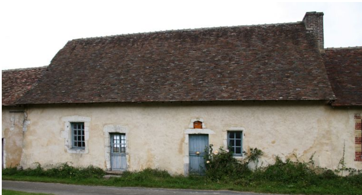
Maison n° 1 : façade sur le chemin.
