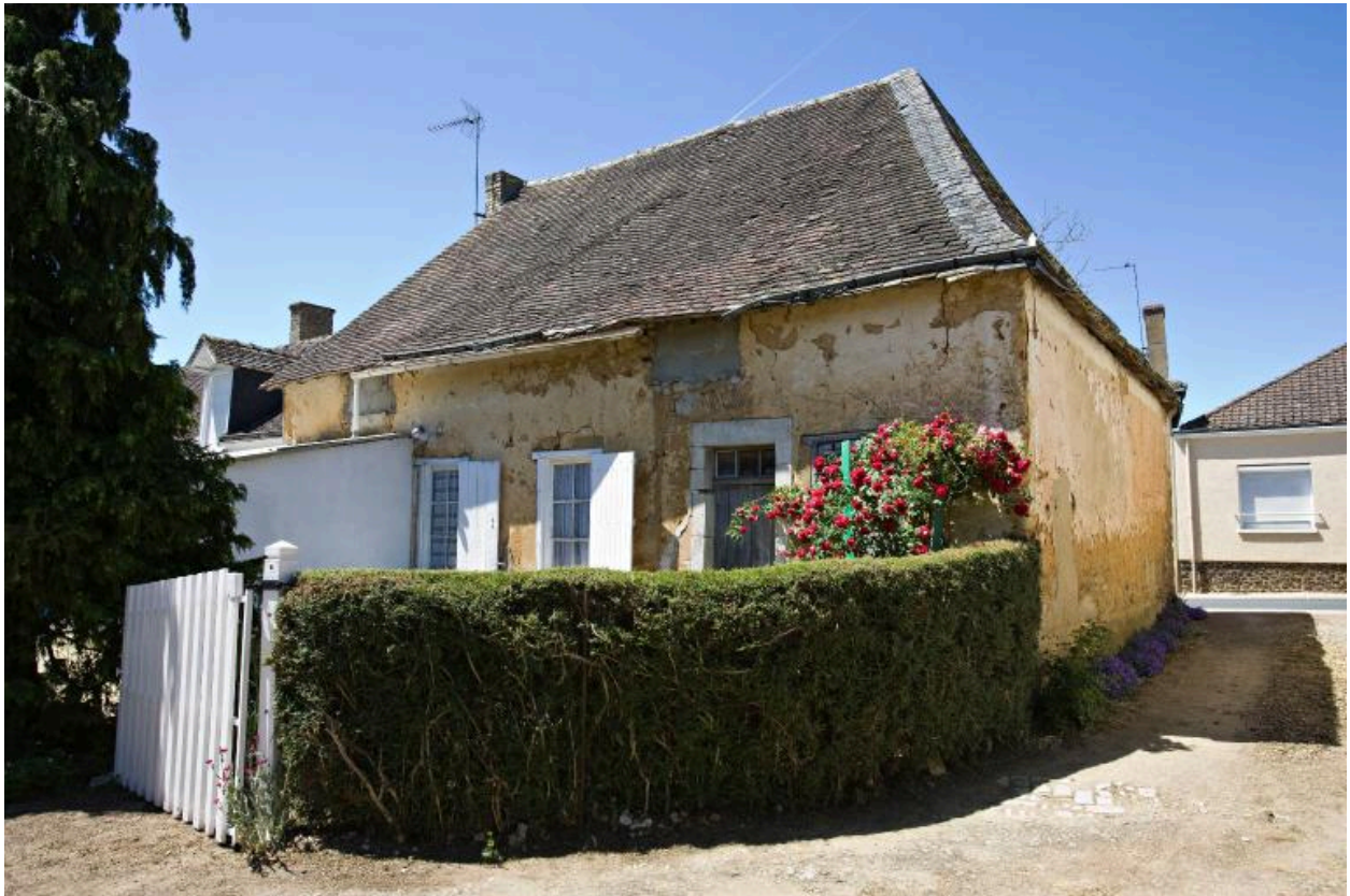
29, rue principale, élévation postérieure. Maison construite sur l'alignement en 1861 pour Jean Picquet, marchand drapier, remaniée vers 1876 (devanture de boutique)
