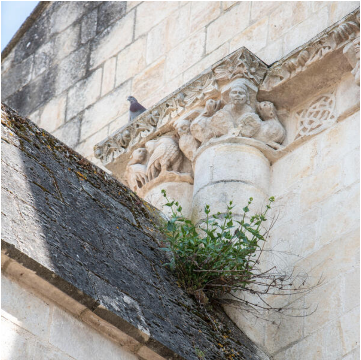
Chapiteaux des colonnes doubles, au-dessus des contreforts, à gauche.
