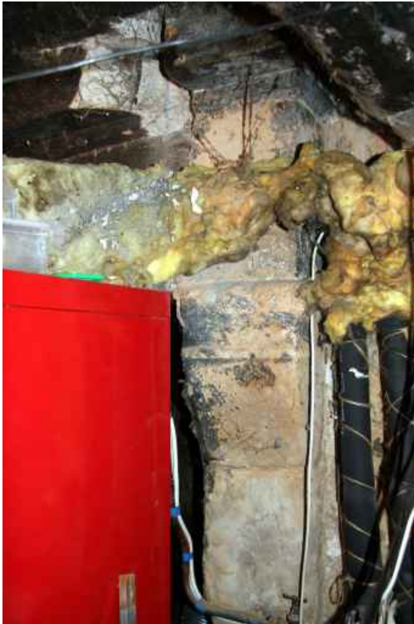
Rez-de-chaussée : vestige d'une cheminée du XVI e siècle.
