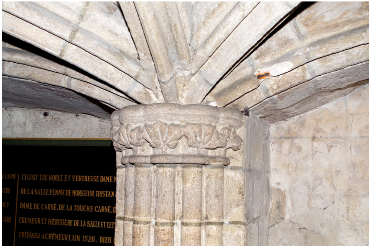
Crypte ou chapelle basse, détail d'un faisceau de colonnette sur le mur sud.
