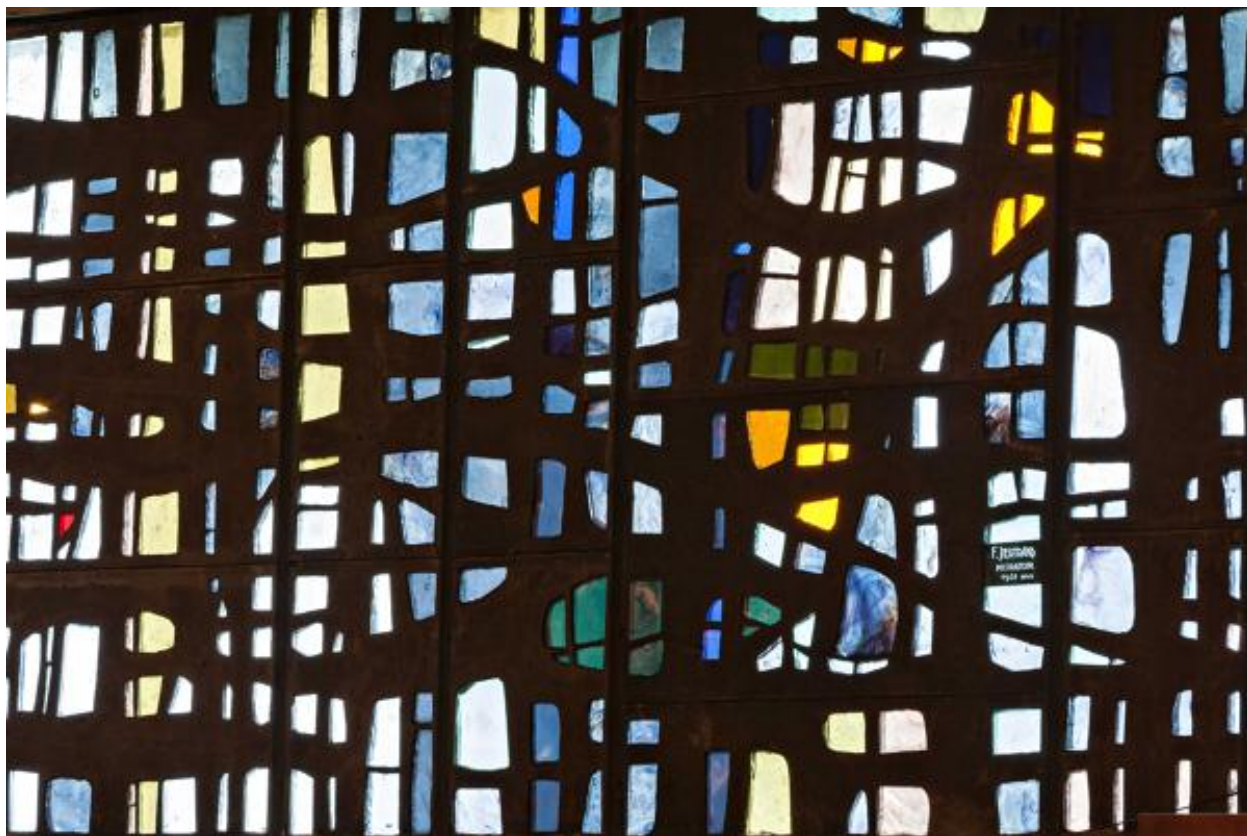
Vue du bandeau vitré en partie supérieure du mur nord.
