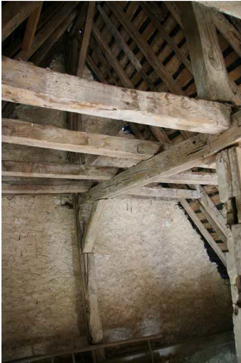
Corps de logis principal : sous-faîtage.
