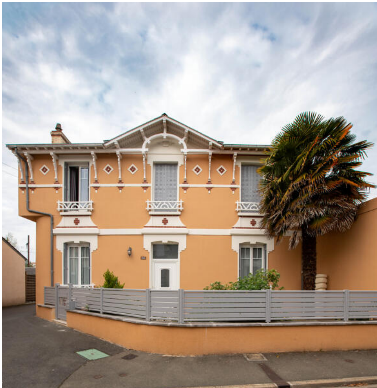
Vue d'une maison de type villégiature rue Henri-Barbin.
