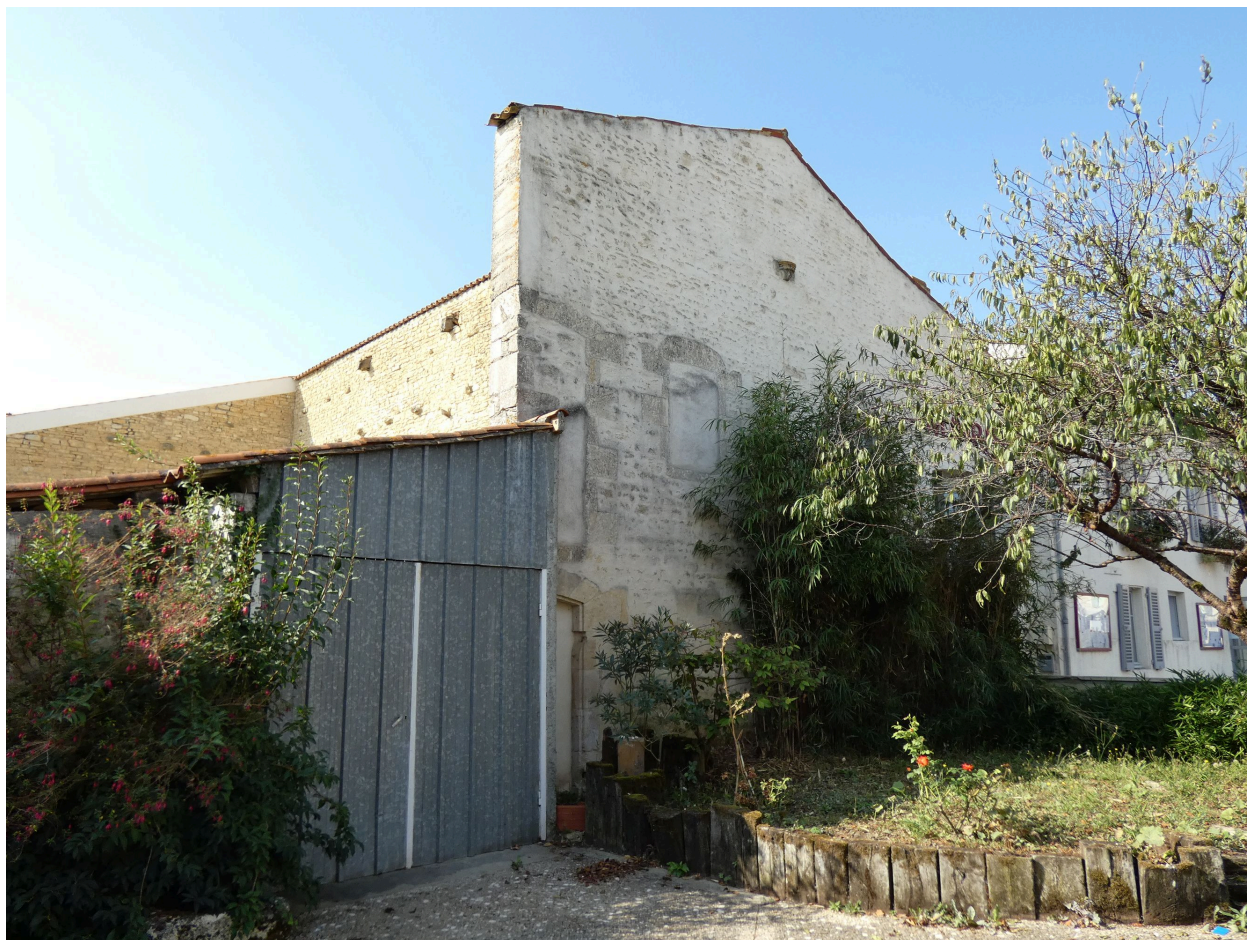
Le mur pignon nord du corps de bâtiment à l'est, vu depuis le nord-est.
