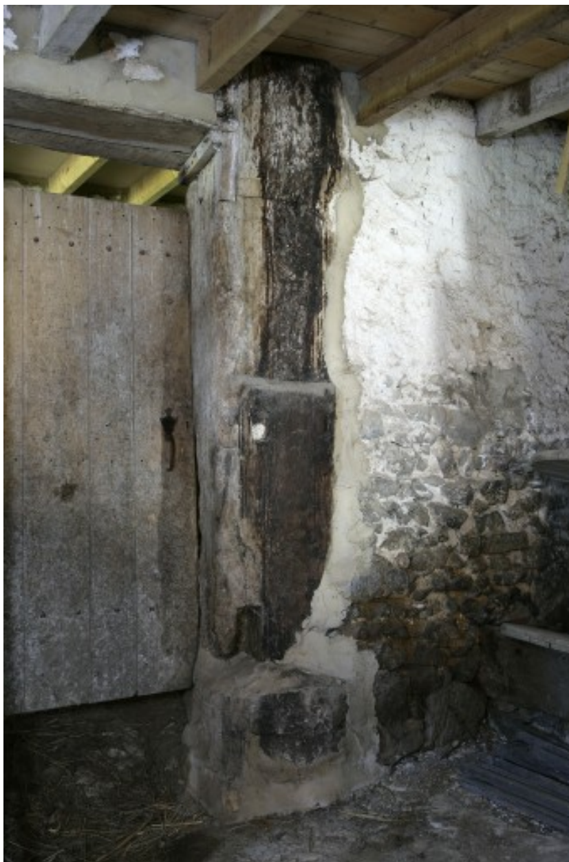
Grange-étable : la partie inférieure du poteau sud-est vu depuis le nord-est.
