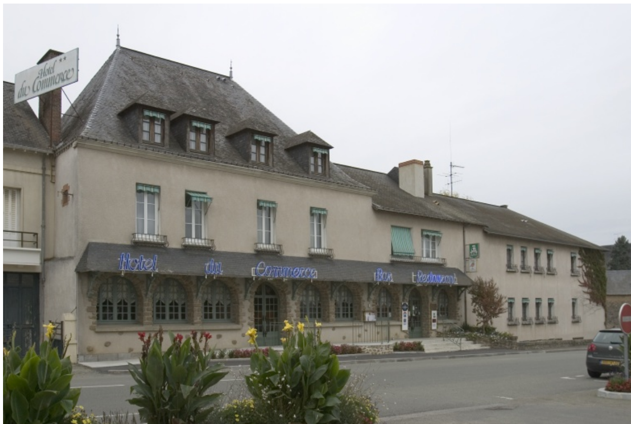
Vue d'ensemble depuis la rue à l'est.
