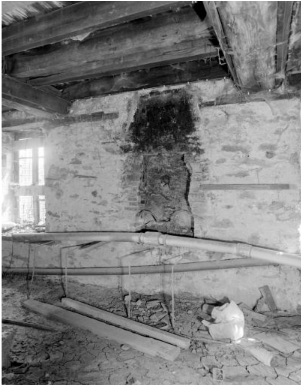
Cheminée, sur le mur sud au rez-de-chaussée du moulin.
