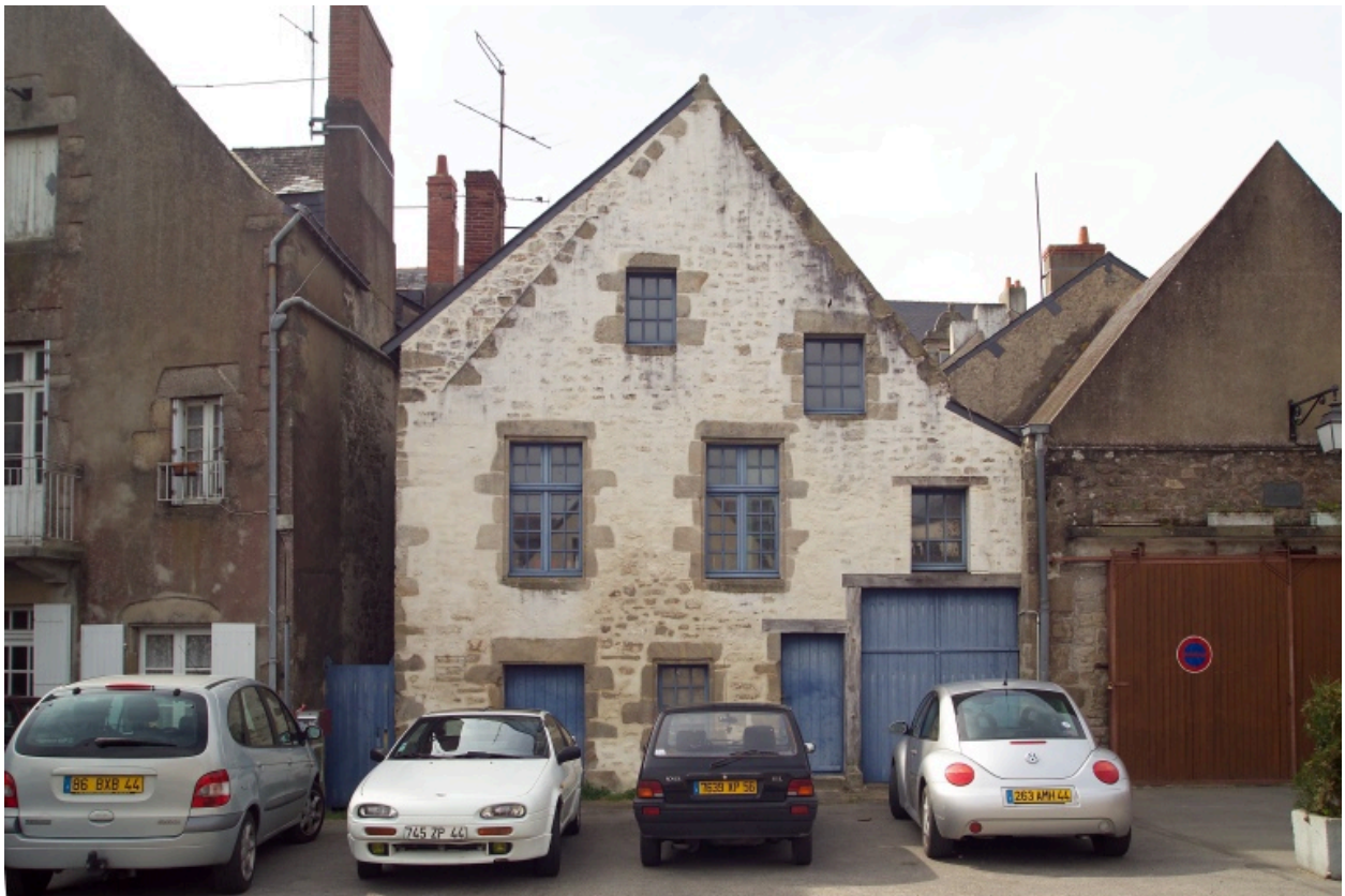
Vue de la façade à pignon sur la Place Saint-Jean.
