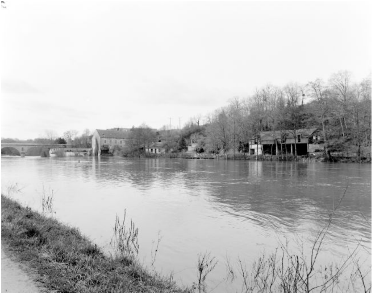
Vue d'ensemble de l'ancienne usine depuis la rive gauche en amont.
