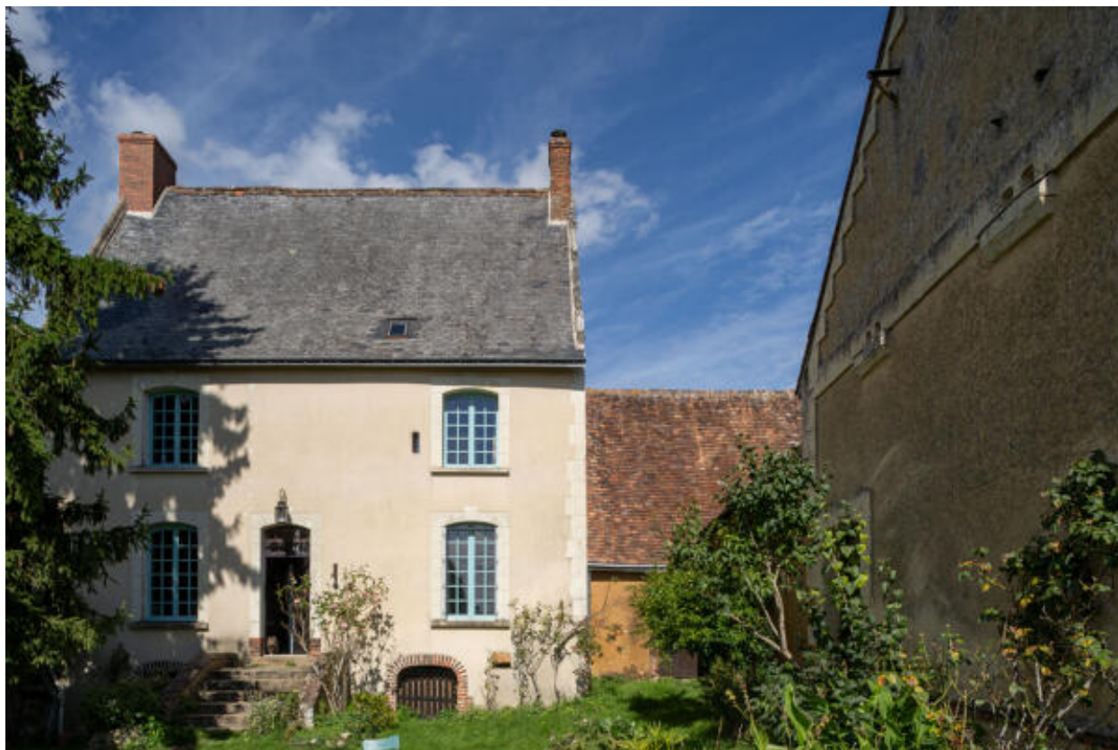
Vue partielle de l'édifice depuis le sud : façade du logis et dépendances.
