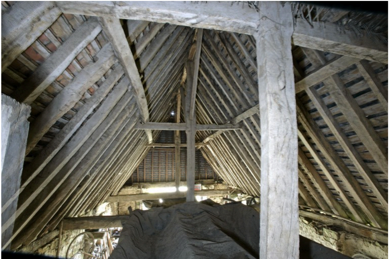
La charpente du premier logis-étable vue depuis le sud-est.
