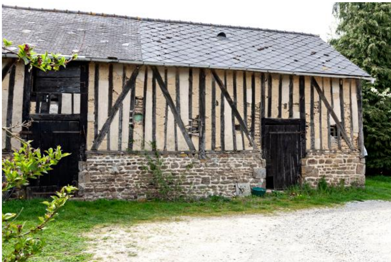
Etable-grange de la ferme de la Petite Basse-Cour.
