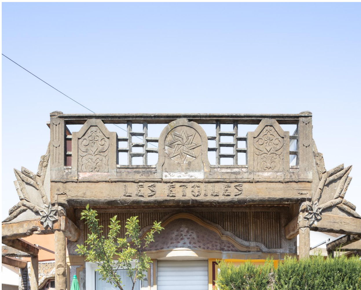
Vue de la rambarde au-dessus de la porte.
