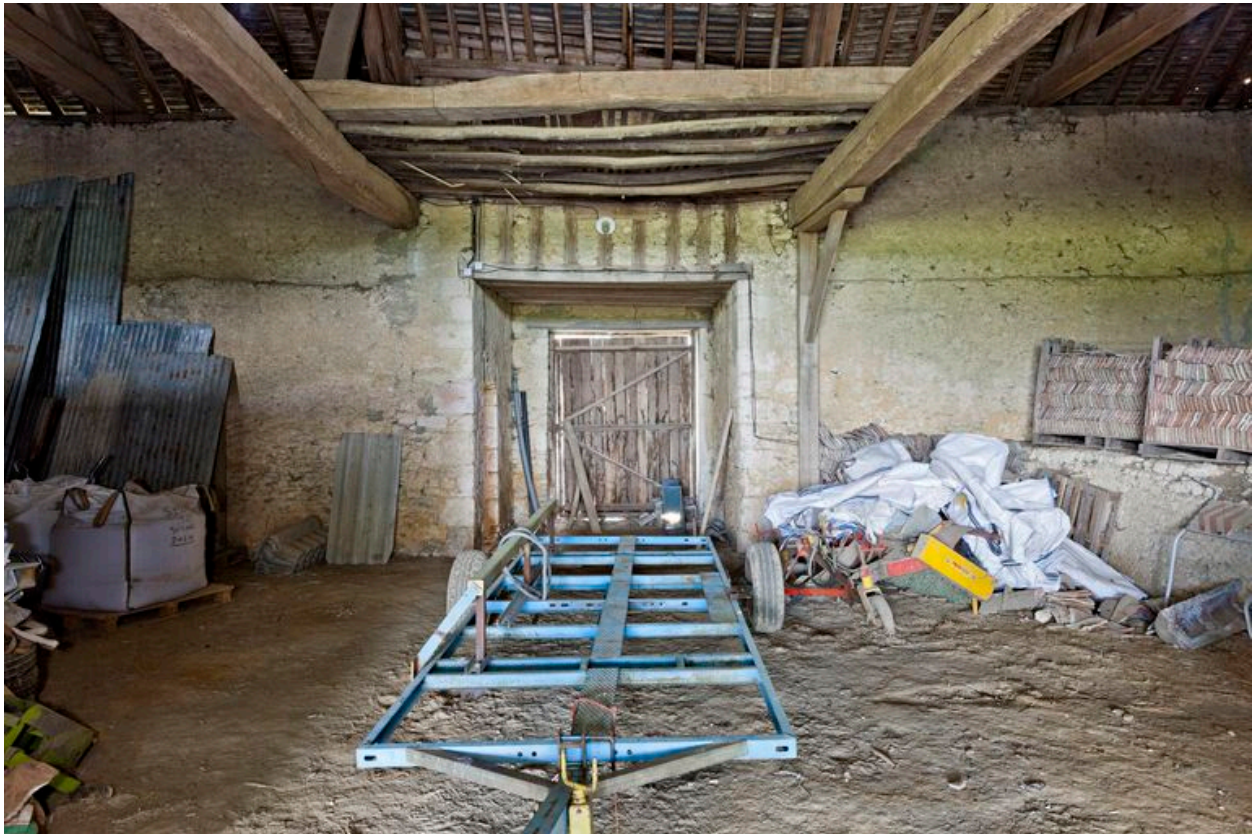
Elevation interieure de la grange-étable-fenil et ancienne élévation postérieure en pan-de-bois du colombier
