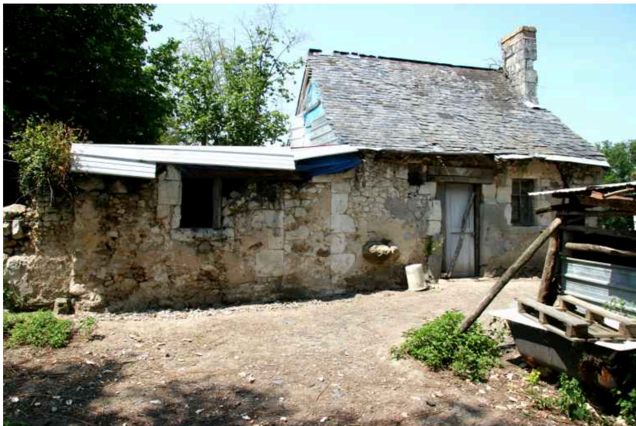
maison 1 : façade antérieure.
