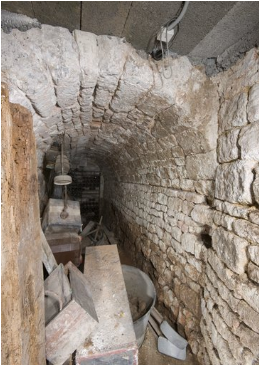
Couloir du sous-sol (vue prise du nord, en direction de la salle de la figure 12).
