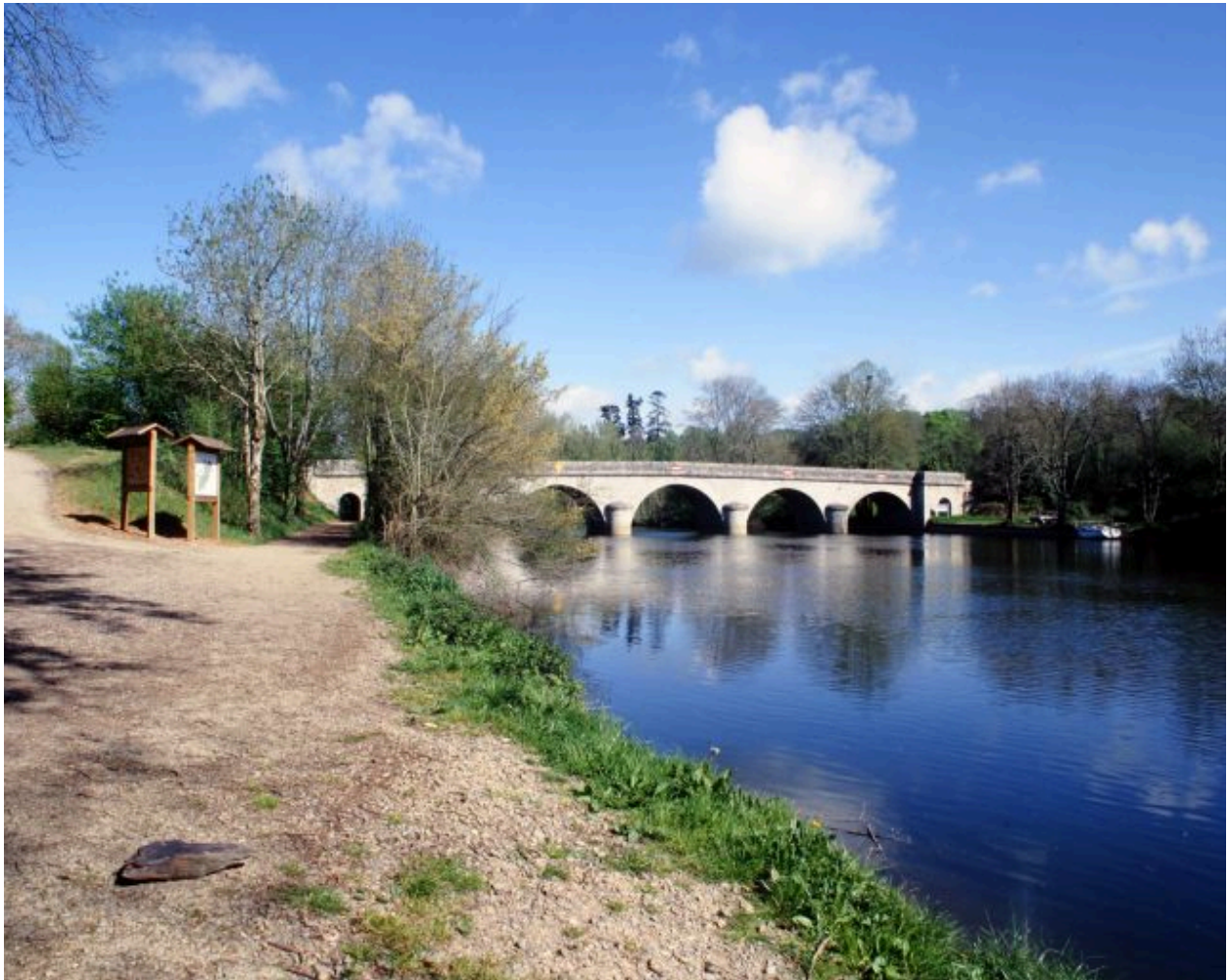
Vue d'ensemble depuis le chemin de halage sur la rive droite, en aval.
