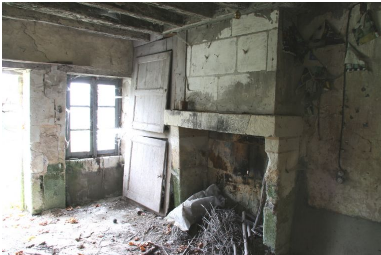
Cheminée de la chambre.
