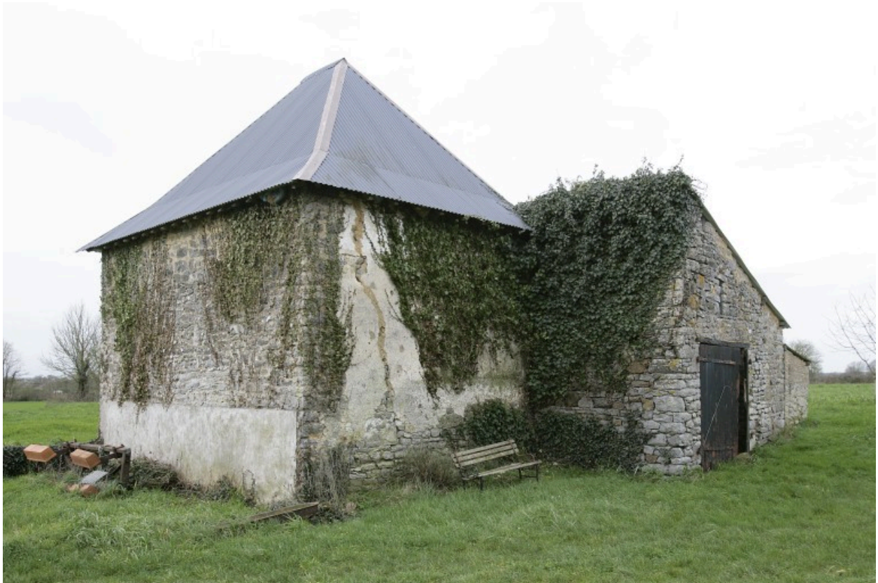
La chapelle vue depuis le nord-est.
