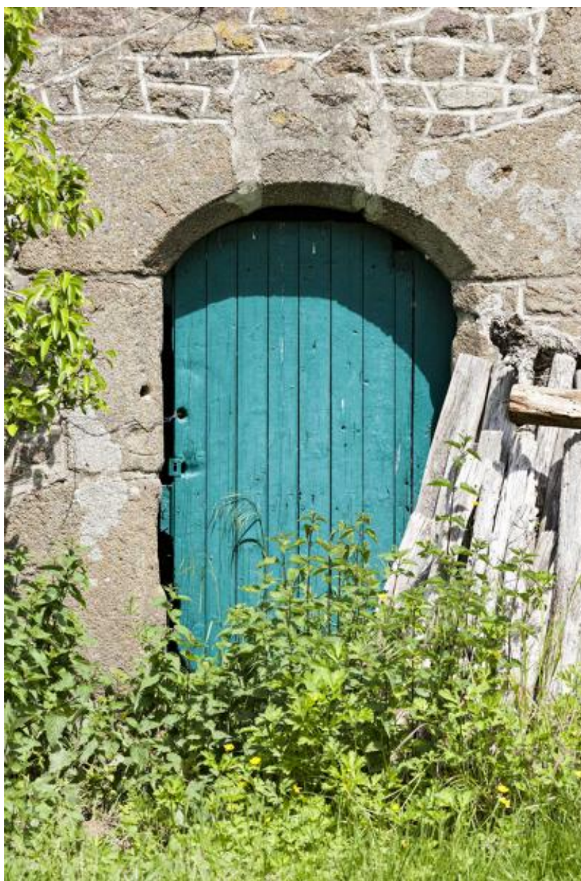
Porte ancienne du cellier du corps de bâtiment principal.
