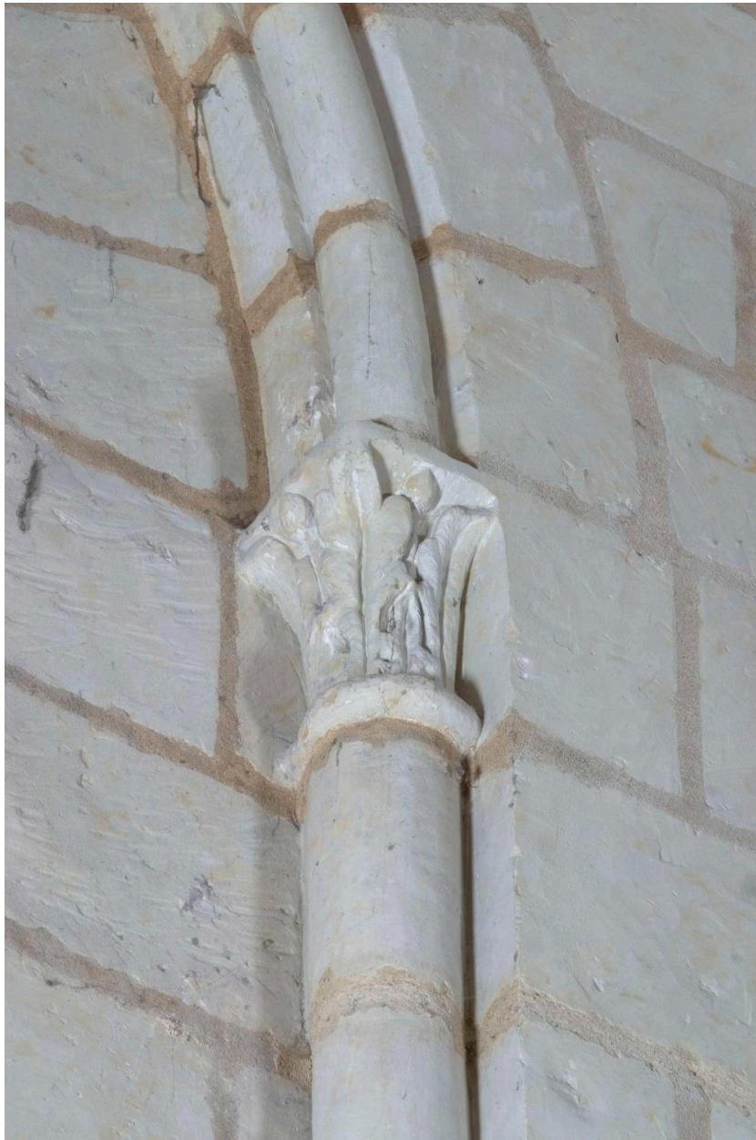
Chapelle Saint-Eloi. Première travée, baie sud, chapiteau de la colonnette ouest (droite)
