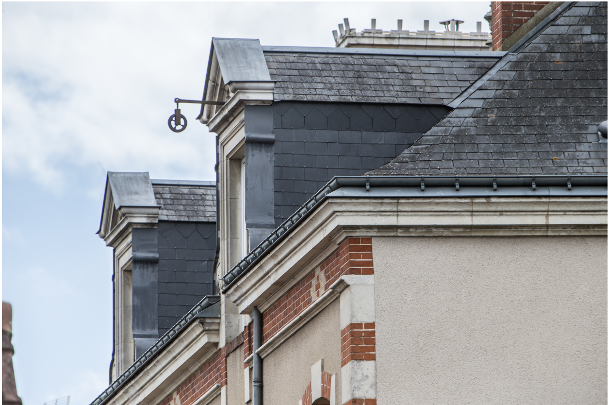
Les lucarnes de la façade arrière.
