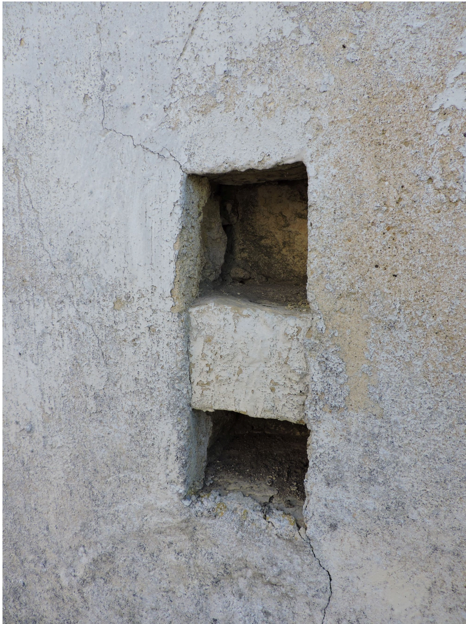
Anneau d'attache aménagé dans le mur de façade de la grange-étable.
