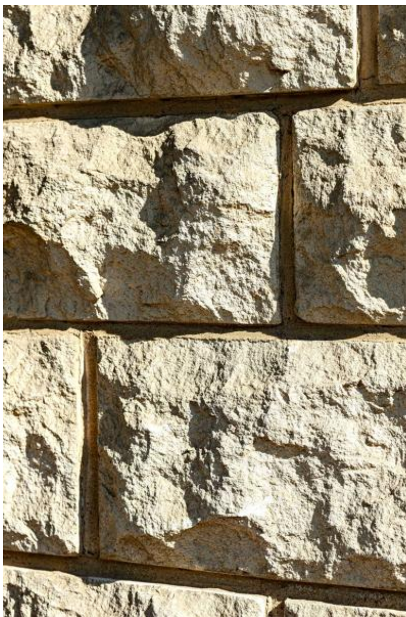
Vue de la pierre en parement de la façade principale.
