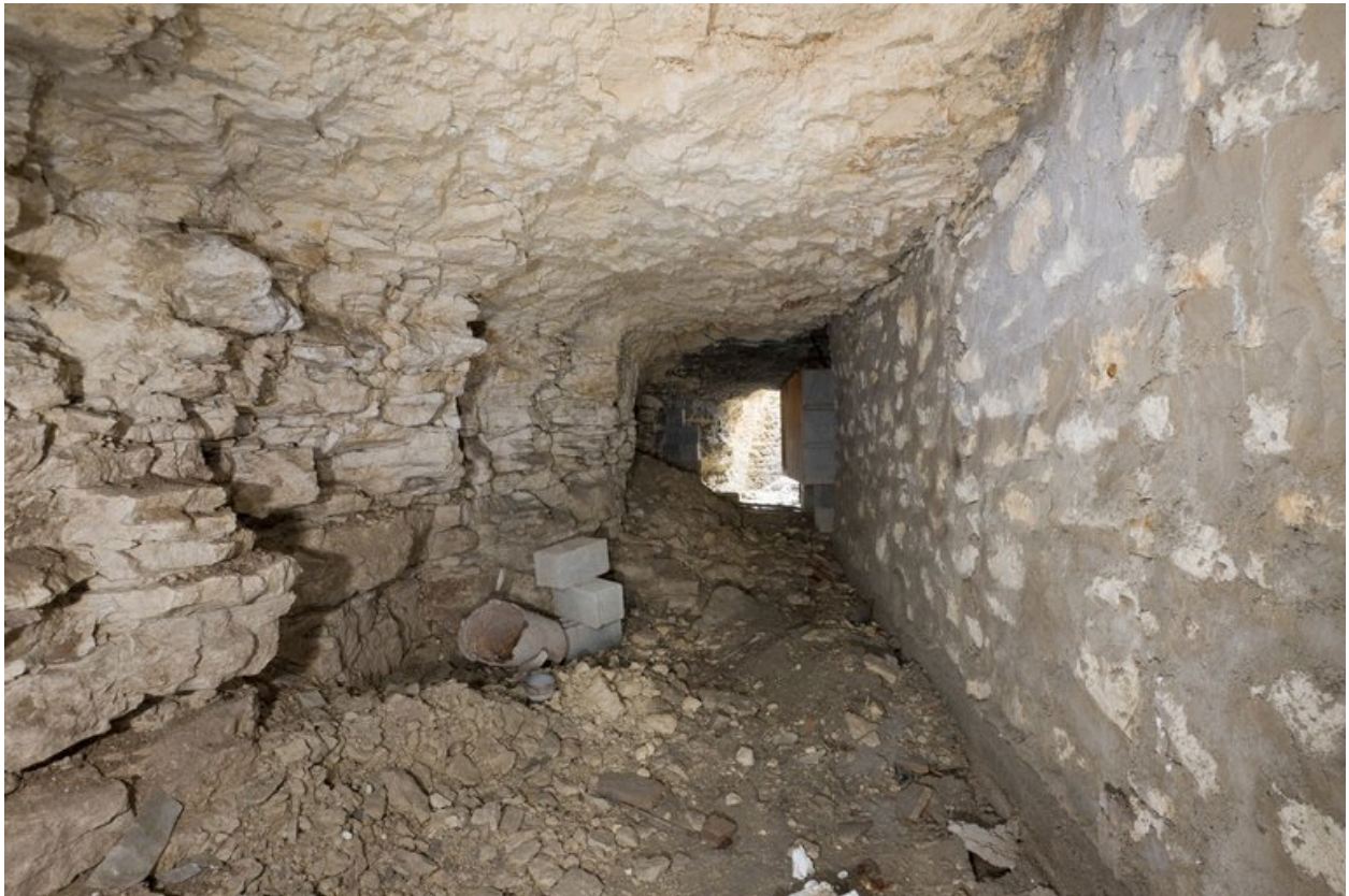
Sous-sol de la maison 5, place du Petit-Booth : vue prise du nord du boyau principal.
