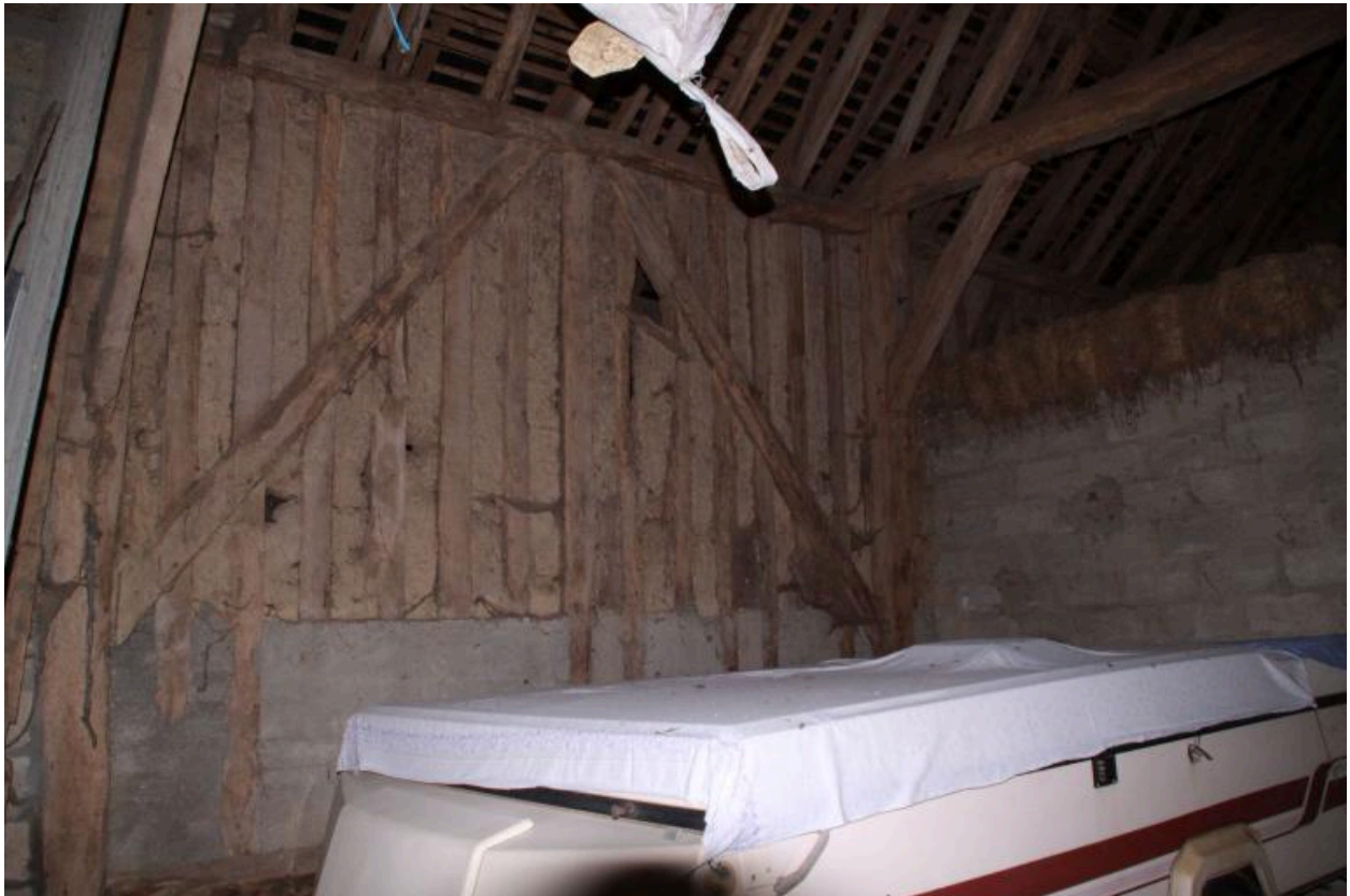
Grange-étable : mur à pan de bois à grille.
