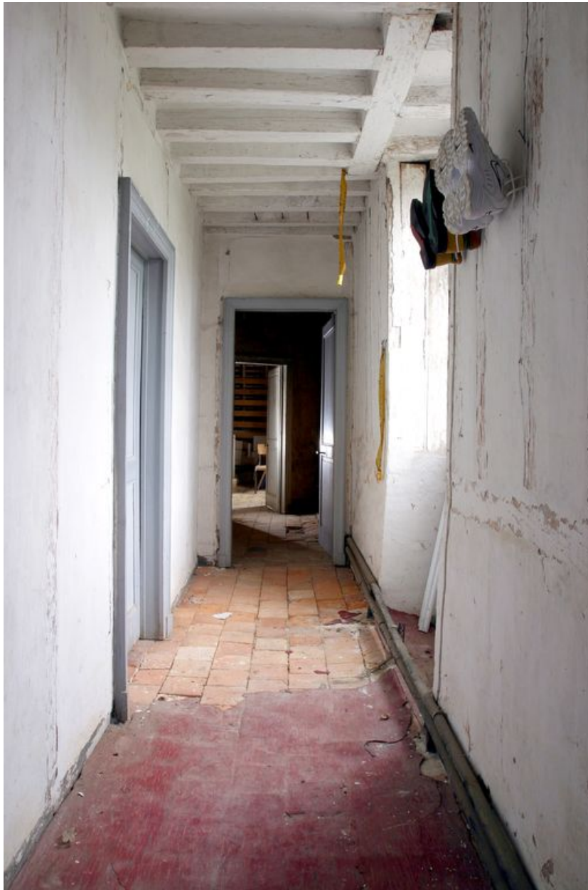
Etage de comble : le couloir vu depuis le sud.
