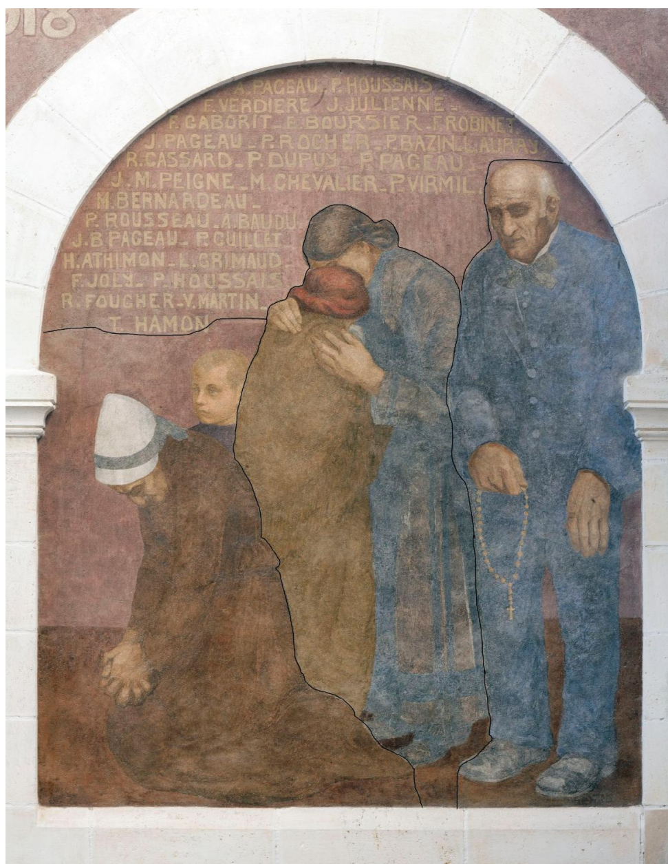
Nef, mur ouest. Monument aux morts, côté droit : la famille du soldat, détail des limites de l'enduit.
